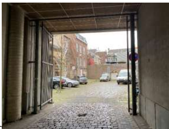
Foto 2: onderdoorgang gezien vanaf het achter terrein
