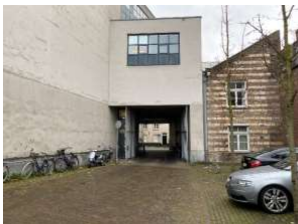
Foto 1: onderdoorgang gezien vanaf het achter terrein
